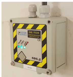
Bilde1: CO detektor type VM-CO-GDC.2 med to alarmgrenser og varsel for komponentfeil
